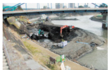
工事中の現場
