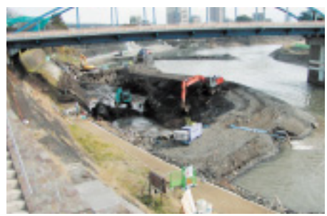
工事中の現場
