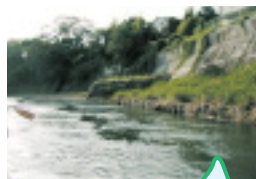
6.26水害後に造られたと思われる石列。右岸を守る。
