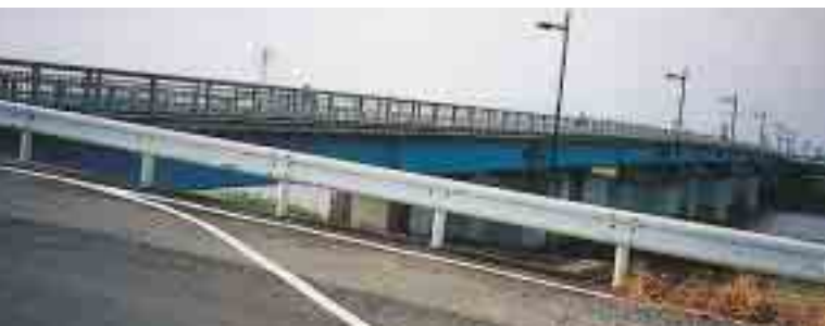
八城橋下流右岸から
