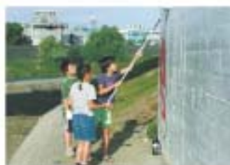
■橋脚落書き消し
