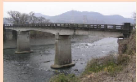
右岸上流より弓削橋をみる
