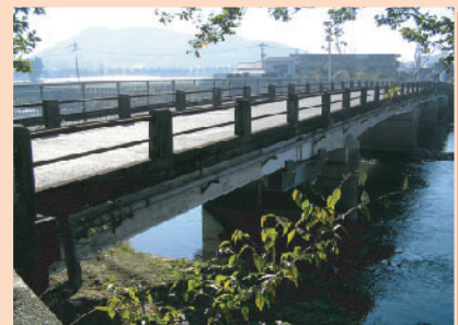
白川右岸橋下流より見る
