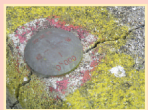
白川左岸河口にある距離表。「距離表・建設省・0k000」と書き込まれた直径5cm程の金属板が堤防に埋め込まれている。
