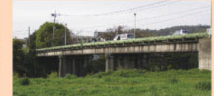
下流左岸側からみる龍神橋。上水道管が見える。
