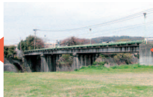
もともと水道を通す橋でした。
