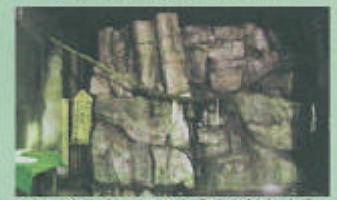
<トンネル内奥、ここから水が流れ出る>
